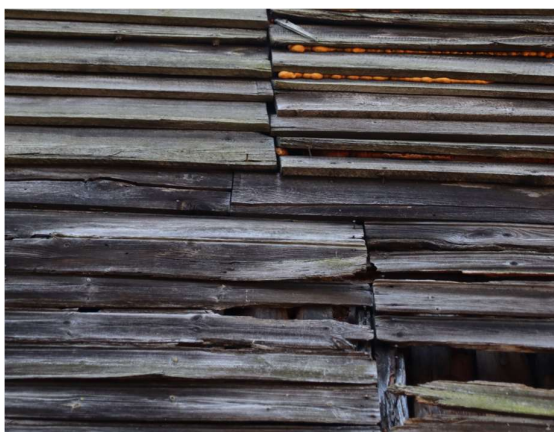
FF Nr. 4.3 Šiaurinės sienos fragmentas. Puvinio pažeistos, atsilaupiusios apkalo lentelės. Tarpai užtaisyti drėgmę kaupiančiomis montazinėmis putomis
