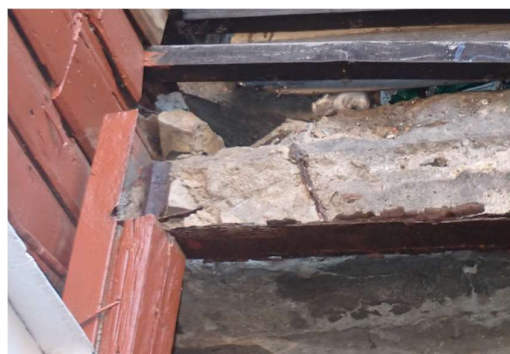
FF Nr. 4.8 Pietinis fasadas. Nurūdijusi metalinė laiptų aikštelės sija.
