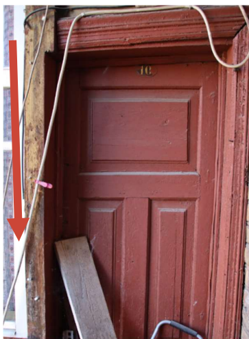
FF Nr. 3.10 Pietinio fasado, rytinės dalies įėjimo į antrąjį aukštą durys (nenaudojamos). Nusmukusi staktos dalis dėl galimo sienos konstrukcijos pažeidimo.
