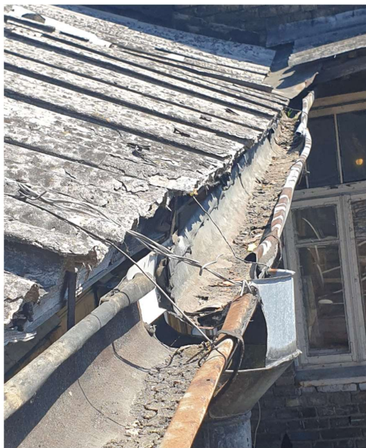
FF Nr. 2.1 Deformuotas lietlovis rytinėje dalyje pritvirtintas vielomis. Dėl nepakankamo nuolydžio ir nepriežiūros jame užsilaiko sąnašos, prarastas apsauginis cinko sluoksnis.
