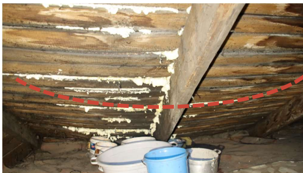
FF Nr. 0.1 Nulūžusi gegnė ir įsmukęs stogas rytinėje pusėje.
