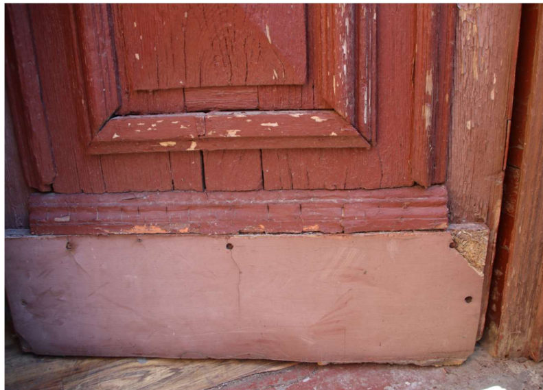
FF Nr. 4.6 Durų fragmentas. Papuvusi, užkalta medžio drožlių plokštė, nuolat drėkstanti apatinė durų dalis, atsivėrę plyšiai, netekčių vietose įstatytos kito profilio detalės, pradėję luptis dažai.
