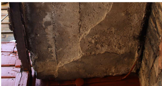
FF Nr. 4.7 Pietinis fasadas. Pavojingai pakibusi laiptų aikštelės betoninė plokštė.
