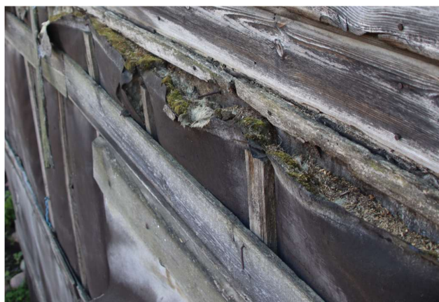
FF Nr. 4.4 Šiaurinės sienos fragmentas. Pirmas aukštas apkaltas konstrukcijoms vedintis trukdančiu tolimi. Viršus atsilupęs, pro jį į vatą skverbiasi drėgmė.
